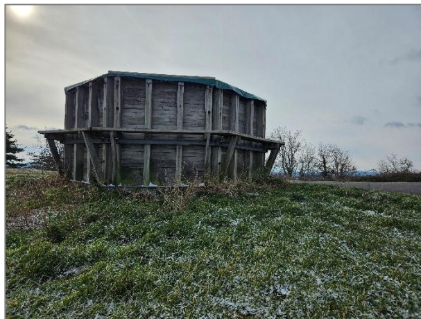
Citerne incendie chemin du Combeau
