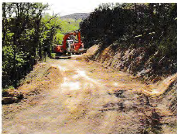
Création de fossé et remblaiement du mur de soutènement route de Champatier.
