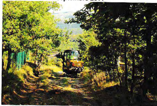
Petits travaux de voirie (curage de fossés etc.) réalisés par l'Entreprise SOUBEYRAN.
