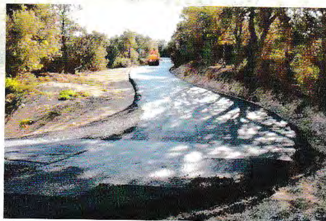
Goutailler-Chazalet : mise en place du tapis d'enrobé par l'Entreprise EIFFAGE
