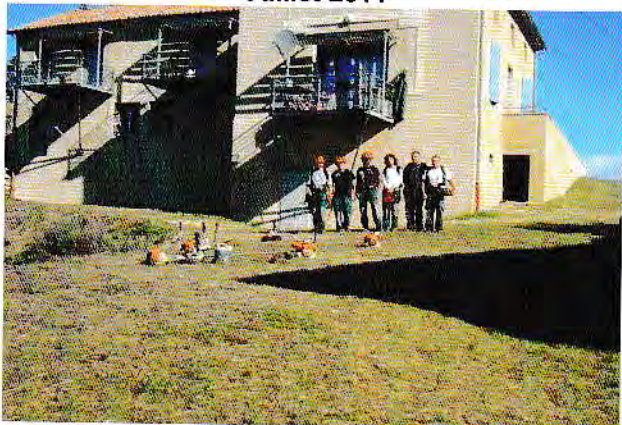
Travaux de débroussaillage par l'équipe de l'Association Tremplin Insertion autour des bâtiments communaux.
