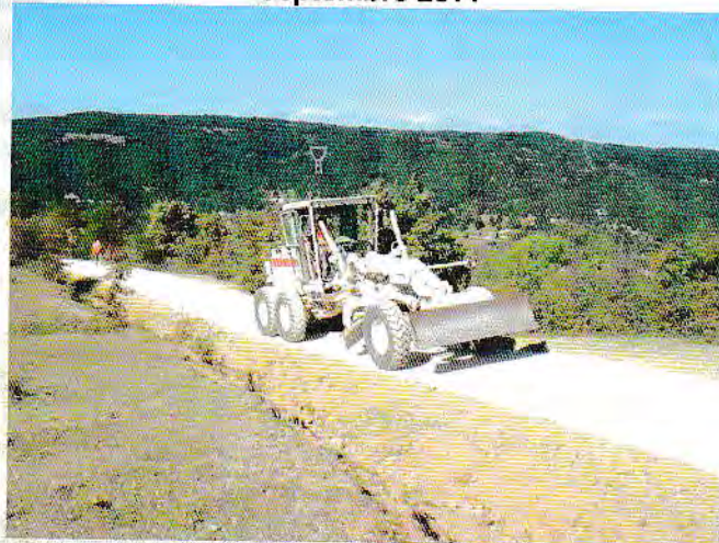
Travaux de préparation pour le revêtement en enrobé de la voie communale Goutailler à Chazalet
